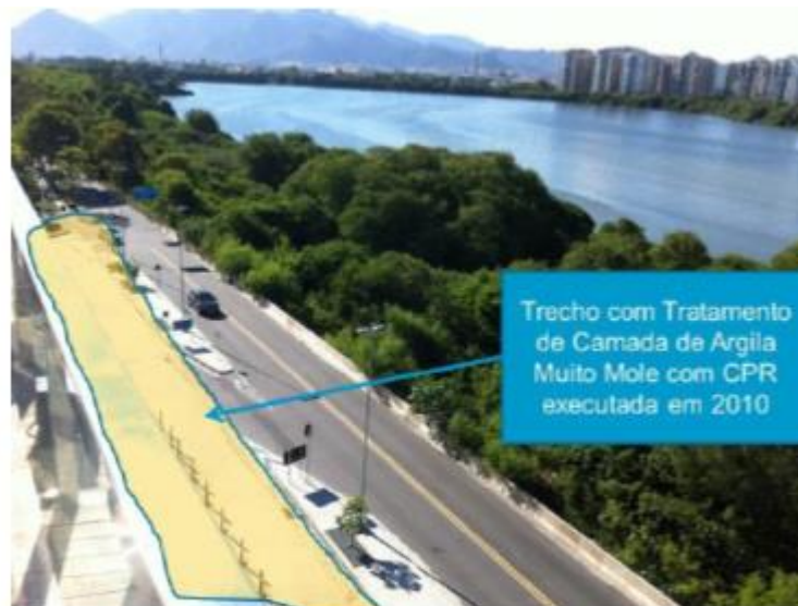
Figura 2. Área de tratamento de solo mole em trecho da Via de Acesso (Geoinfra, 2010)
