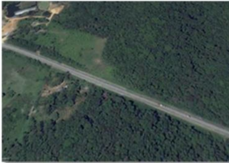
Figura 5 – Vista aérea da encosta antes dos escorregamentos. Fonte: GOOGLE EARTH (2011).
