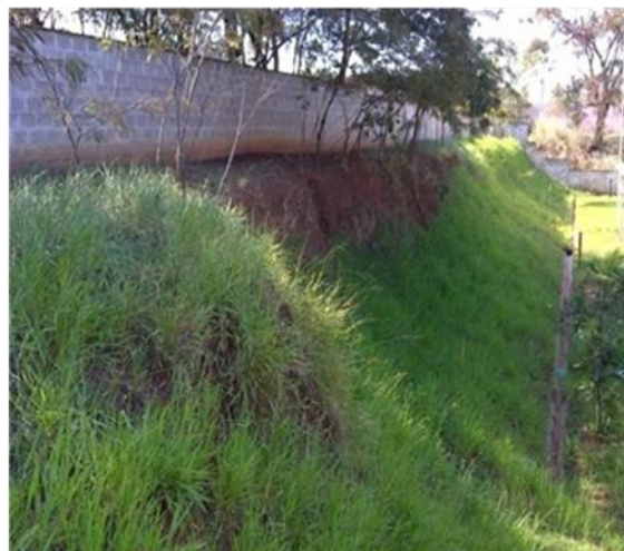
Figura 2. Talude 1 – Casa Vida. Sanches (2015).
