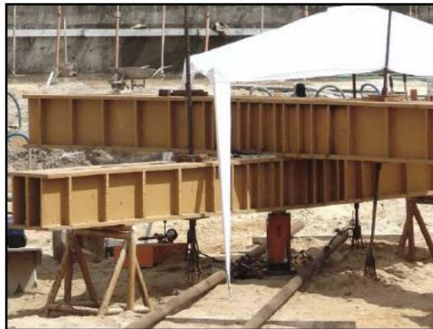
Figura 8: Montagem do sistema de reação.
