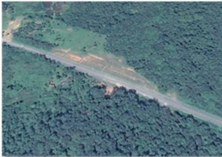
Figura 6 – Vista aérea da encosta já com as obras de retaludamento e drenagem realizadas.
