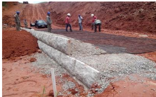
Figura 1. Execução da estrutura de contenção com geogrelhas associadas aos elementos de face pré-moldados de concreto.
