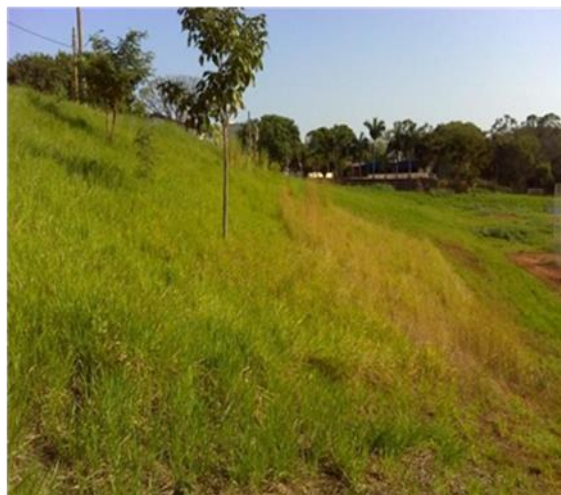
Figura 3. Talude 2 – Ginásio Poliesportivo. Sanches (2015).
