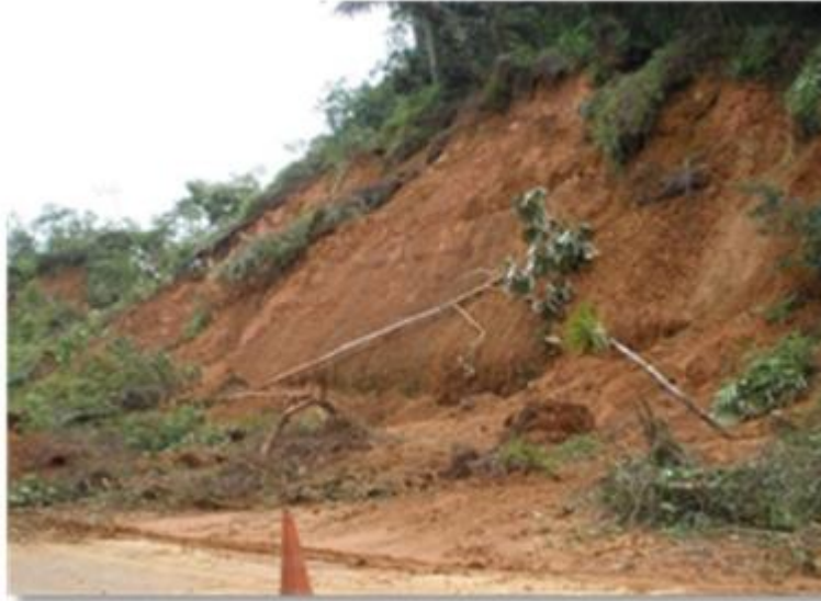
Figura 7 – Ruptura “normal” no 2º segmento do talude. Fonte: ENGEMIN (2011).
