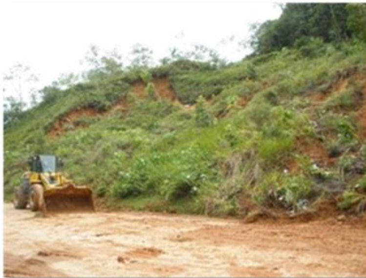
Figura 8 – Ruptura “normal” no 2º segmento do talude. Fonte: ENGEMIN (2011).
