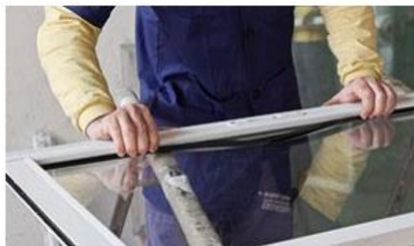
Figura 1 – Vedação da borracha na esquadria
