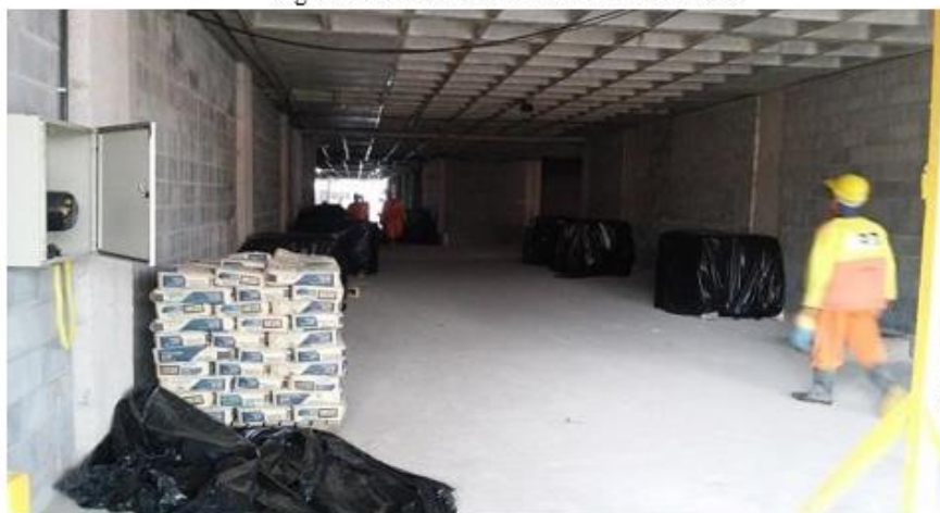
Figura 10- Isolamento dos sacos de cimento
