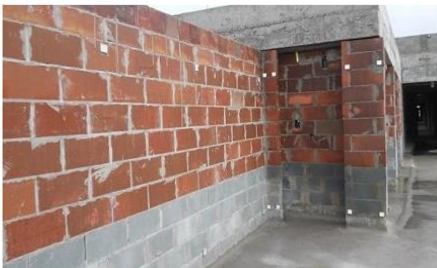
Figura 4 - Alvenaria de blocos modulada
