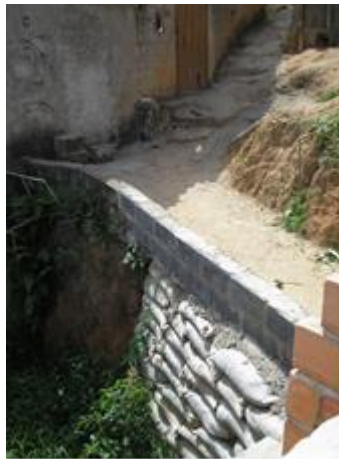
Foto 06: Obra preventiva – Rip-rap – Regional Venda Nova
