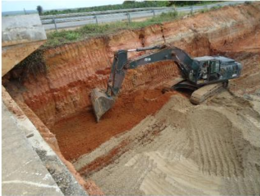
Figura 5. Final da escavação e início da colocação da camada de regularização
