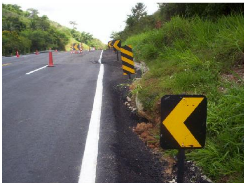
Figura 1 – Movimentação do talude com levantamento da pista.
