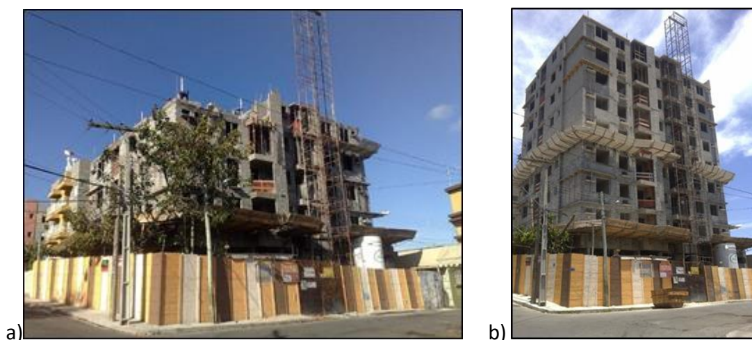
Figura 1. Fotos panorâmicas de agosto 2011 (a) e jan./2012 (b) durante a construção (Fonte: Autor).
