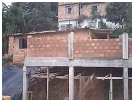
Foto 04: Obra definitiva em andamento – laje – Região Leste de Belo Horizonte
