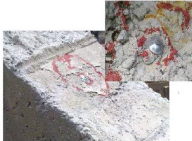
Figura 20 – Pinos de monitoramento instalados na obra.
