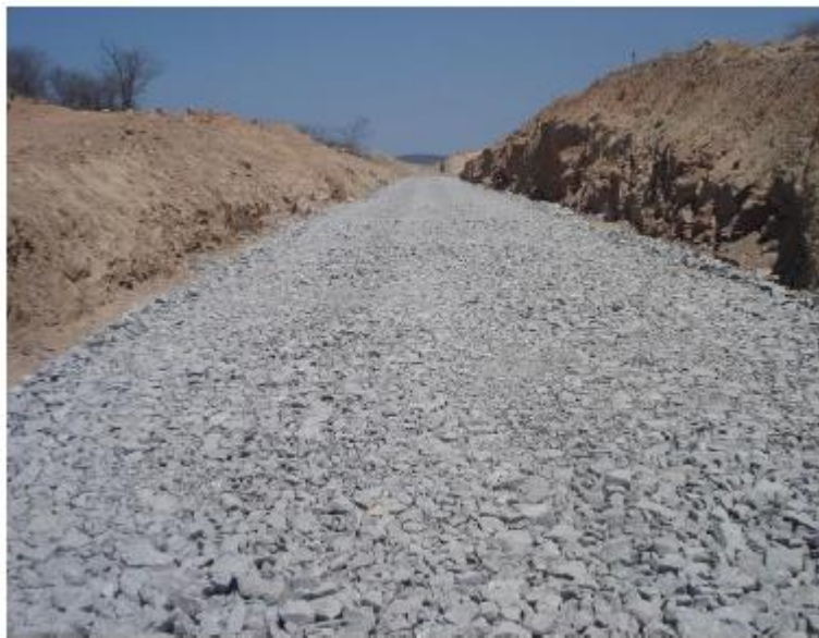
Figura 1. Trecho inacabado da ferrovia.
