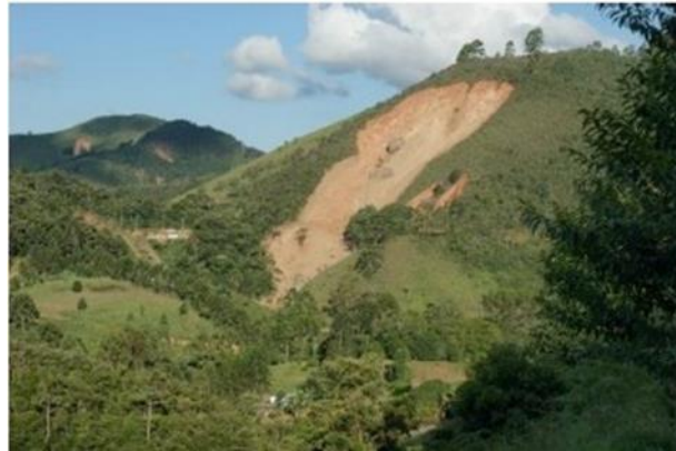
Figura 1- Vista global da encosta após a ruptura
