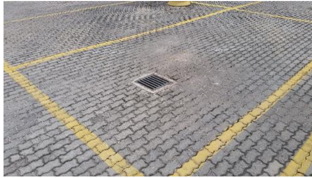
Figura 8. Detalhe da drenagem superficial, por meio de caixa com grelha, interligado ao sistema de drenagem com macdrain.
