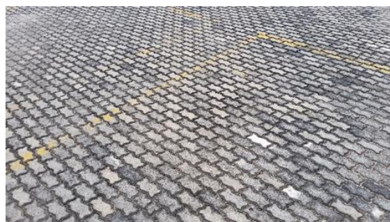
Figura 7. Vista do piso intertravado no estacionamento externo do piso superior.
