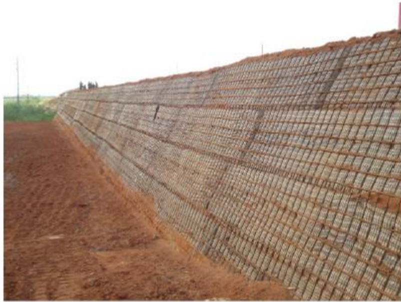
Figura 8. Proteção lateral com biomanta.
