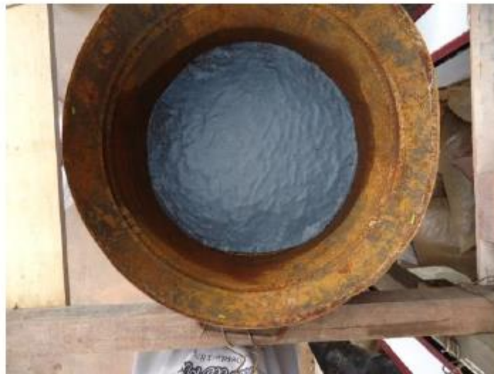
Figura 17- Assentamento da geomanta no tubo metálico.
