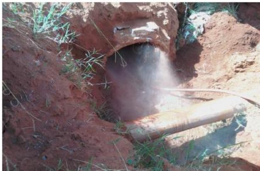
Figura 2. Desobstrução da rede.
