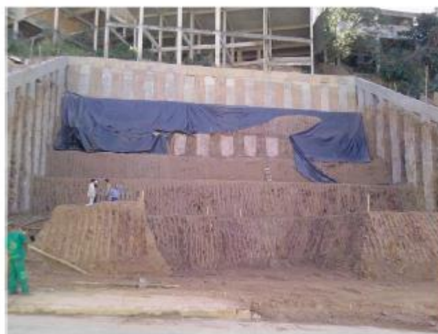
Figura17 - Foto da obra
