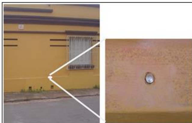
Figura 4. Parafuso RN afixado no alicerce de uma residência vizinha (Fonte: Autor, jan./2011).
