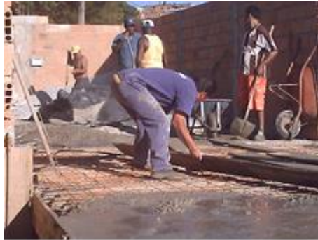
Foto 01: Obra executada com mão de obra do morador em regime de mutirão
