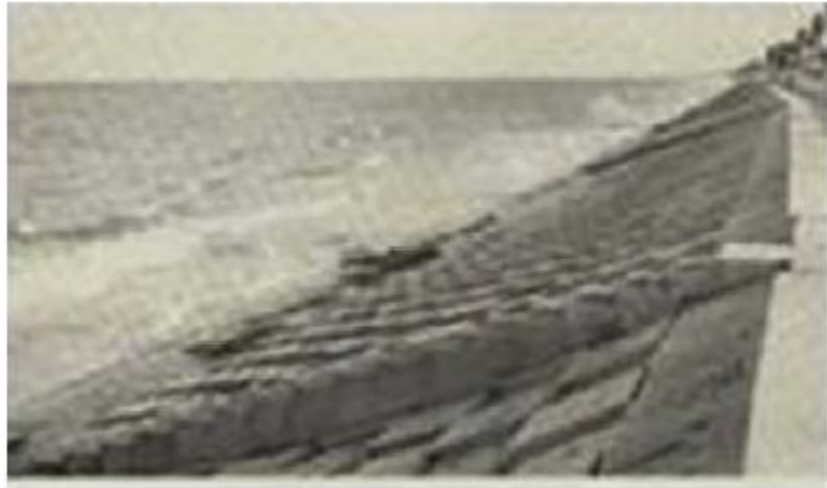
Figura 1. Filtro de geotêxtil sob uma cobertura de talude com blocos. Koerner, 2015.
