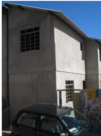
Foto 07: Obra de retorno – Reconstrução de moradia – Região de Belo Horizonte
