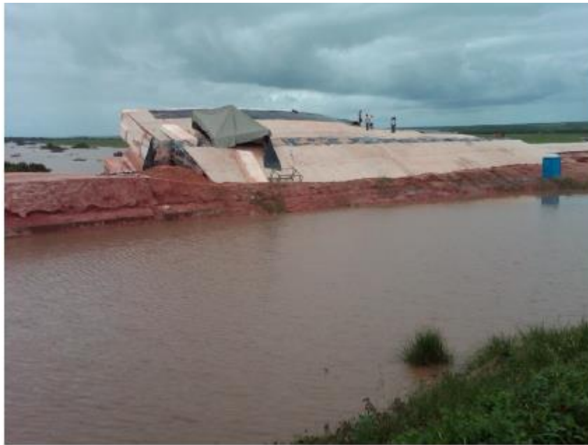
Figura 3. Ruptura do aterro leve devido ao empuxo
