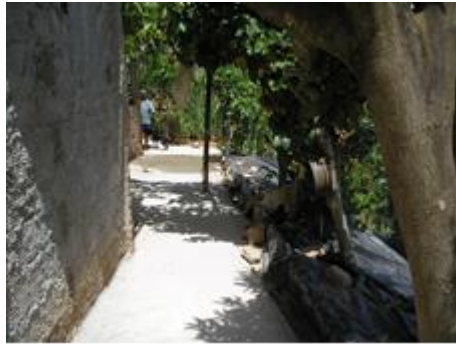
Foto 09: Obra preventiva – Impermeabilização de crista para colocação de lona –Regional Leste
