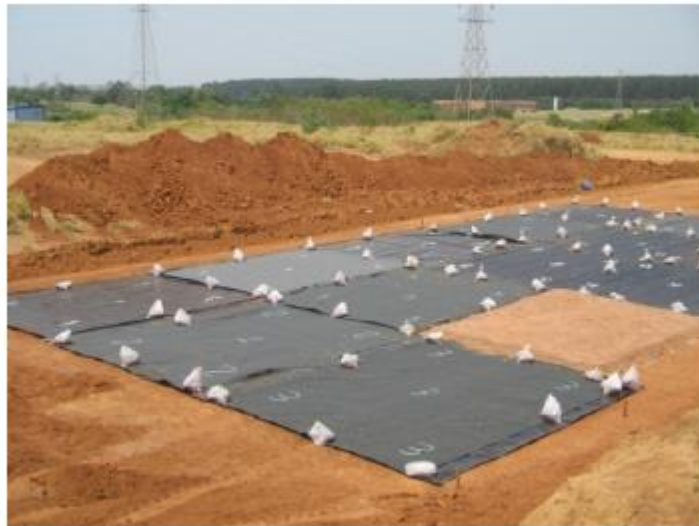
Figura 3. Instalação dos elementos de proteção.
