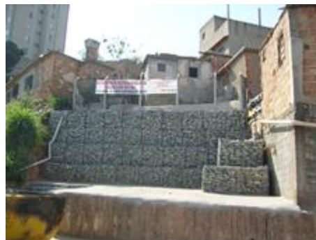
Foto 08: Obra definitiva – Muro em gabião – executado pela empresa contratada- URBEL, região Centro Sul.
