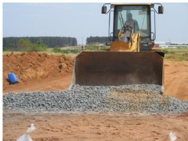
Figura 4. Construção da camada de drenagem.
