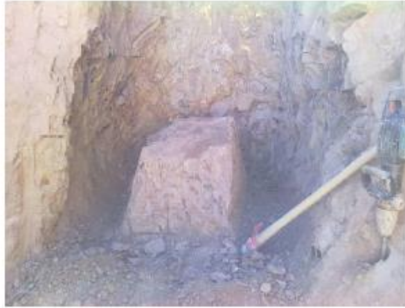
Figura 2 – Bloco sendo retirado na obra.
