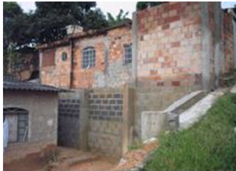
Foto 03: Obra definitiva – muro de contenção – Região Nordeste de Belo Horizonte
