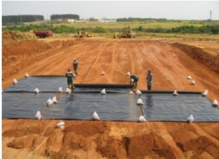
Figura 2. Instalação das geomembranas em baias.
