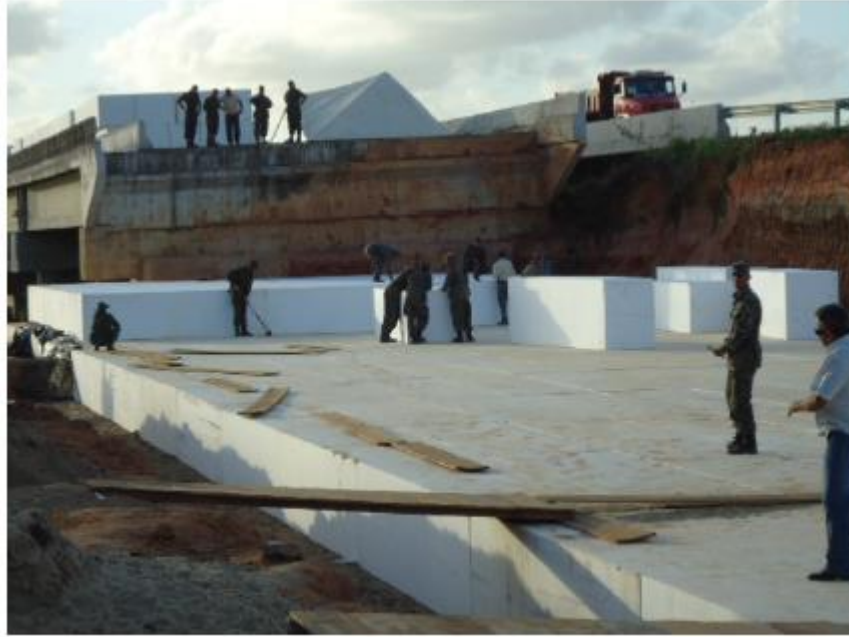
Figura 6. Início da colocação da segunda camada de EPS
