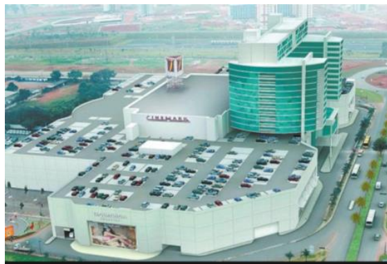
Figura 2. Vista do piso com pavimento intertravado sobre a laje do estacionamento superior do Taguatinga Shopping.
