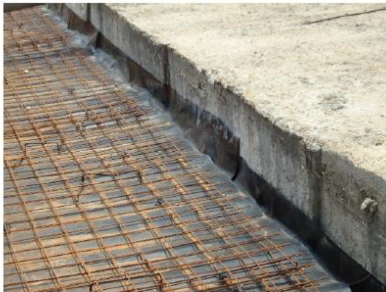
Figura 7. Detalhe da manta e da armação da laje com tela
