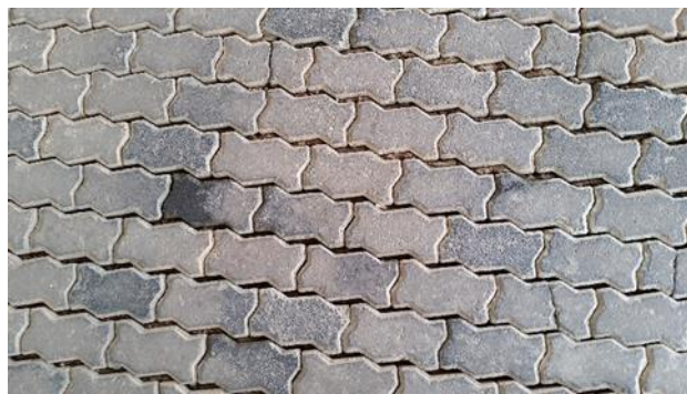
Figura 9. Vista da juntas do piso intertravado.
