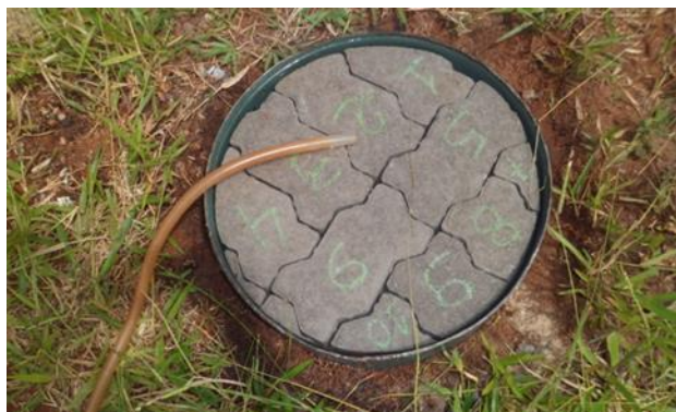
Figura 10. Ensaio de permeabilidade em pisos intertravado.
