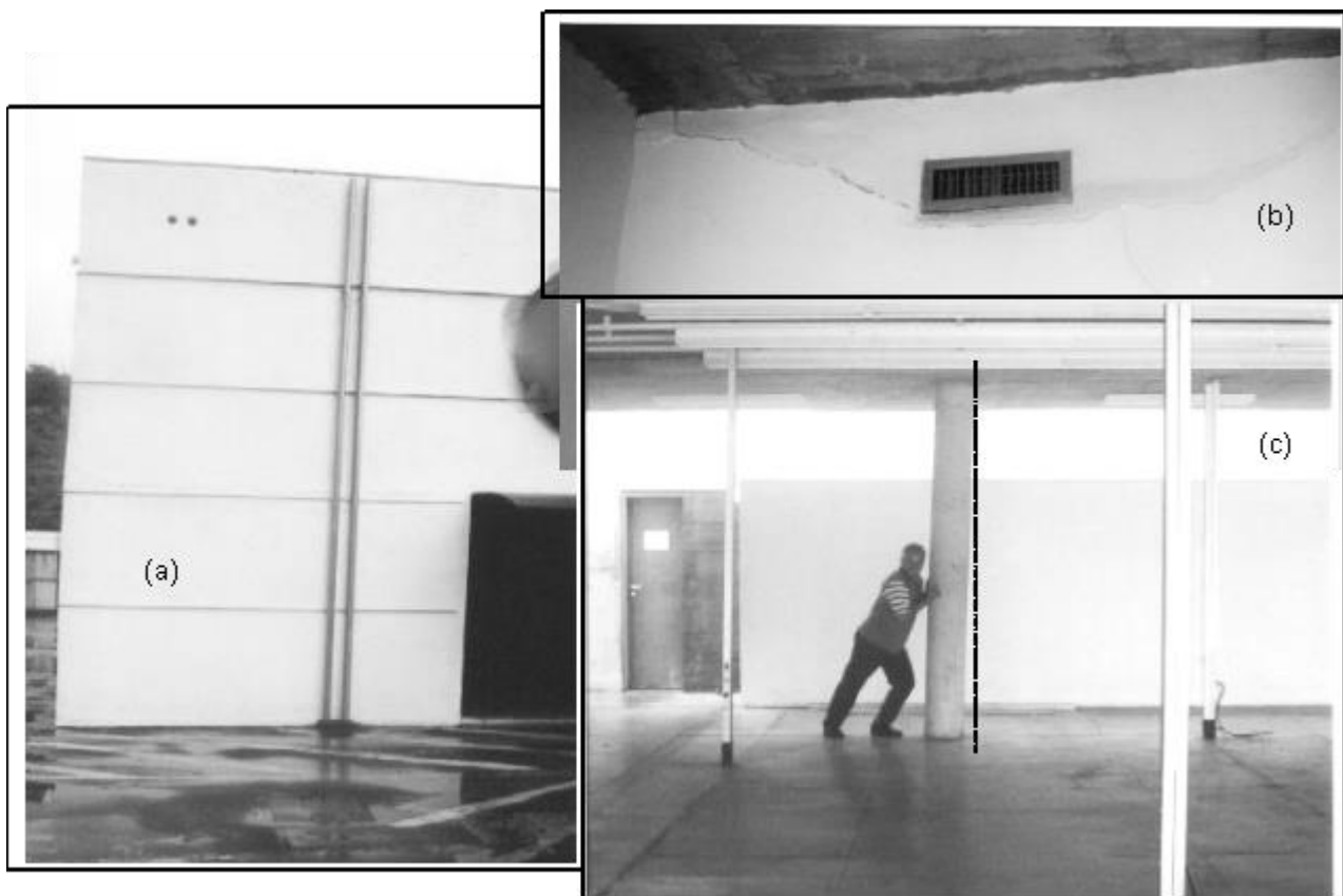
Figura 1: Detalhes dos danos ao prédio: (a) vista frontal, com nítida inclinação da fachada; (b) trinca em parede interna; (c) visível desaprumo de um dos pilares
