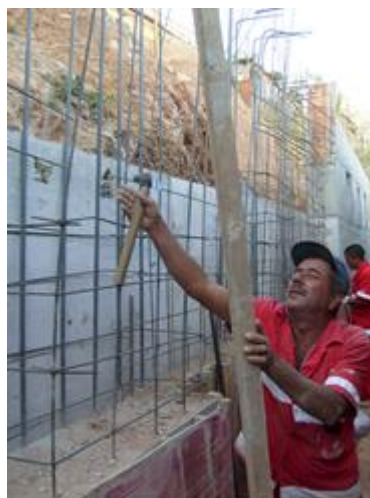
Foto 02: Obra executada por empreiteiras através de empresas contratadas pela URBEL
