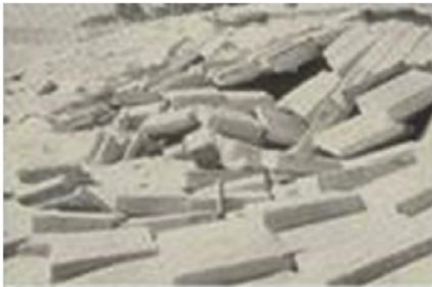
Figura 2. Pressão hidrostática sob o geotêxtil, devido rebaixamento do nível d'água, causou o levantamento e deslocamento dos blocos.
