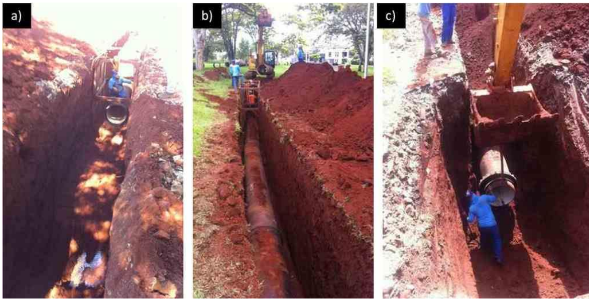
a) e b) Funcionários dentro da blindagem de contenção; c) Funcionários sem o uso da blindagem de contenção.
