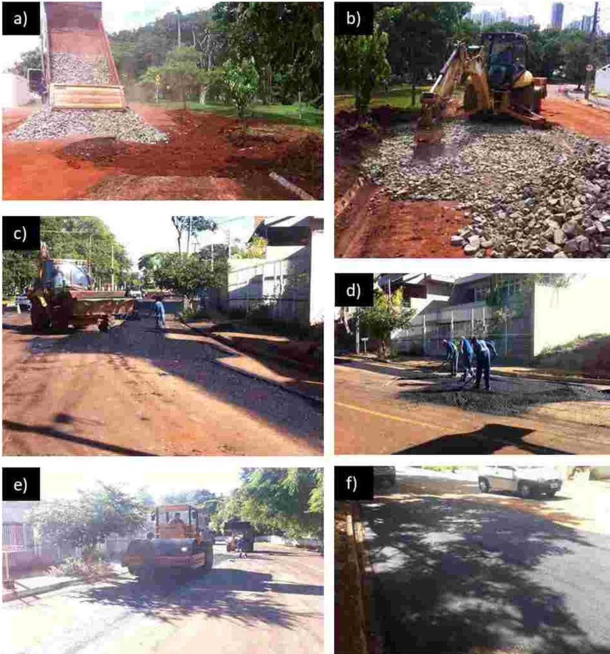
Figura 10 – Fechamento de vala e pavimentação
