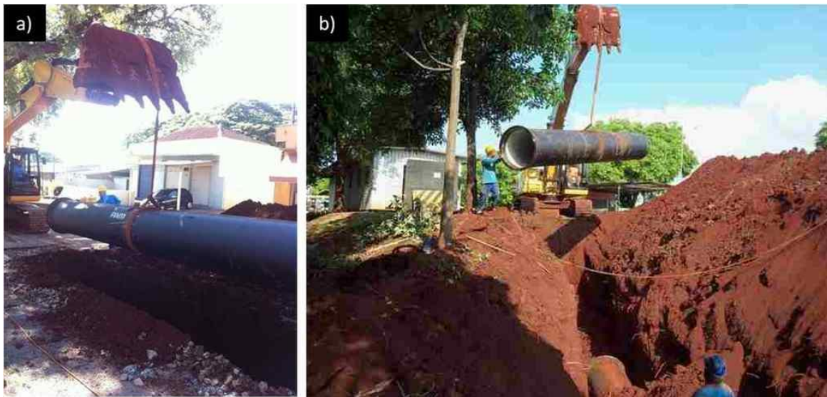
a) Tubulação com cinta de içamento; b) Funcionário guiando tubulação para assentamento em vala.
