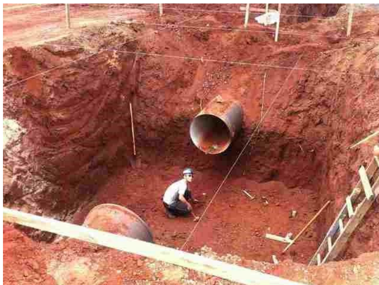
Figura 8 – Locação e alinhamento da tubulação
