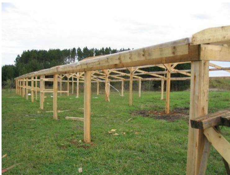
Figura 2. Estufa construída em madeira.
