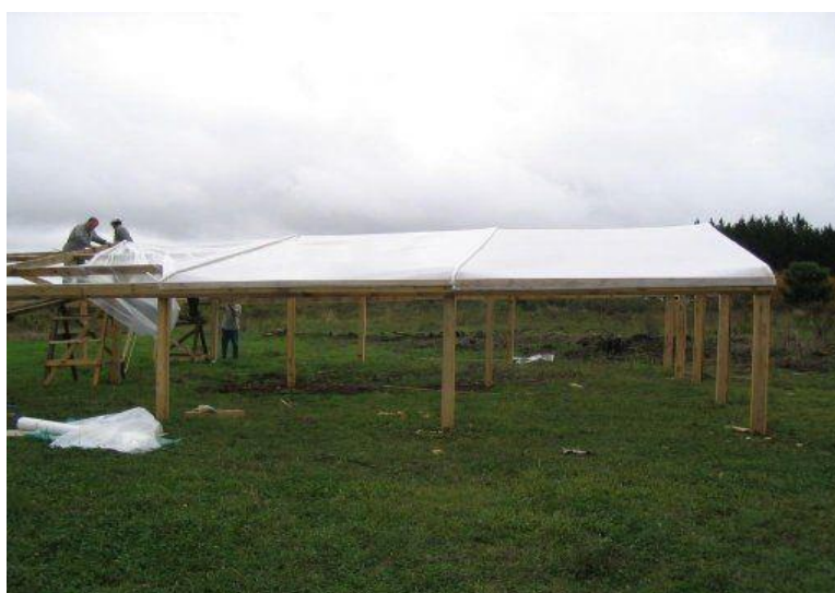
Figura 3. Estufa sendo coberta.
