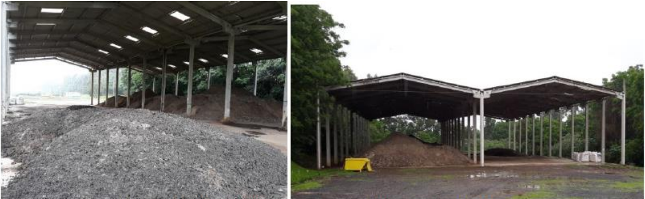
Figura 2 – Pátio de higienização por EAP na UGL ETE Ronda
