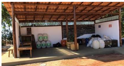
Figura 56: Galpão para armazenamento temporário de resíduos recicláveis e perigosos.
