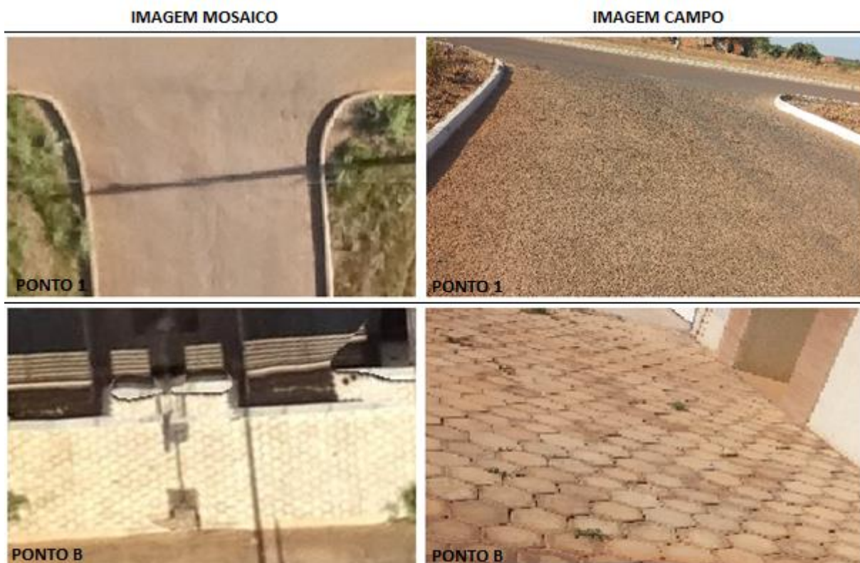
Figura 77. Ponto 1 (Revestimento asfáltico em travessia) e ponto B (Intertravado sextavado).
