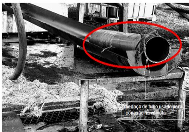
Figura 4. Ilustração do Pedaço de Tubo de 4" usado como Conexão na Válvula
