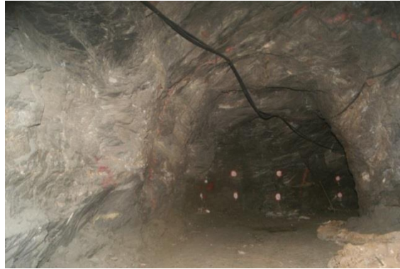
Figura 04. Local de instalação do SMDR juntamente com 03 seções convencionais utilizadas pela Mina
