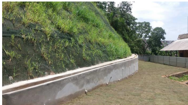
Figura 11. Sistema de drenagem pluvial com muro armado a jusante da encosta. Fonte: Elaborado pelos autores (2018).
