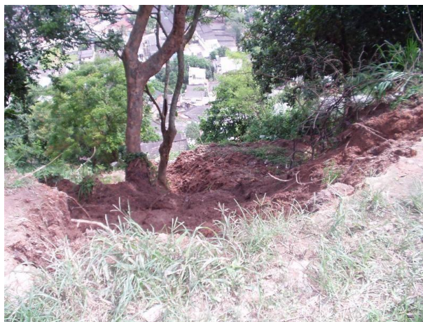
Figura 4. Visão de montante para jusante da cicatriz de escorregamento ocorrido no ano de 2005. Fonte: Projeto MAPENCO.
