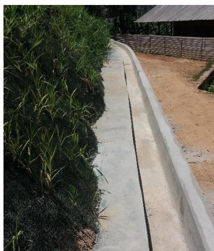
Figura 10. Sistema de drenagem a jusante da encosta.
