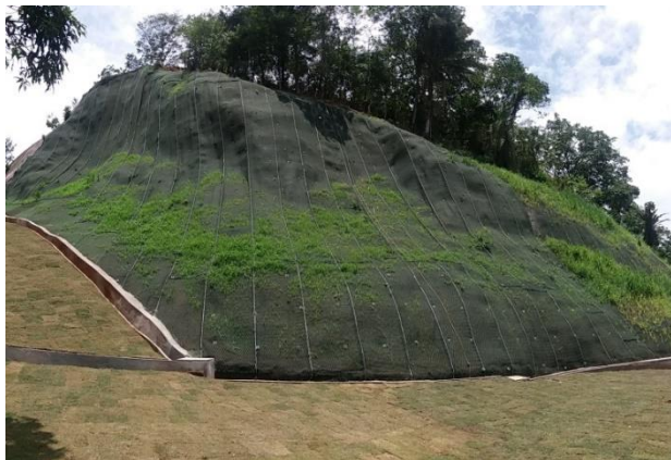
Figura 12. Situação após intervenção.
