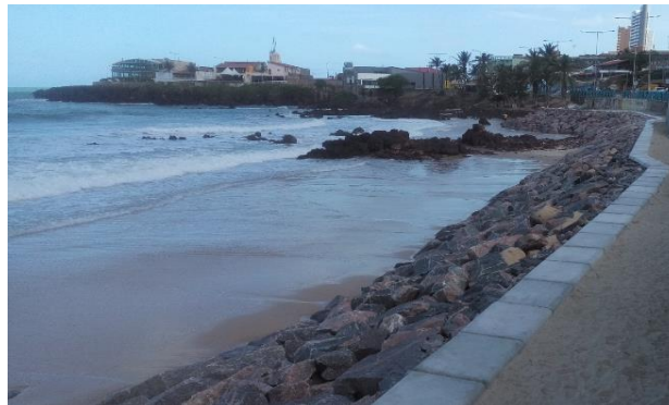
Figura 5. Obra de Enrocamento Aderente na Praia do Meio em Natal/RN, em execução (2017). Fonte: Própria.
