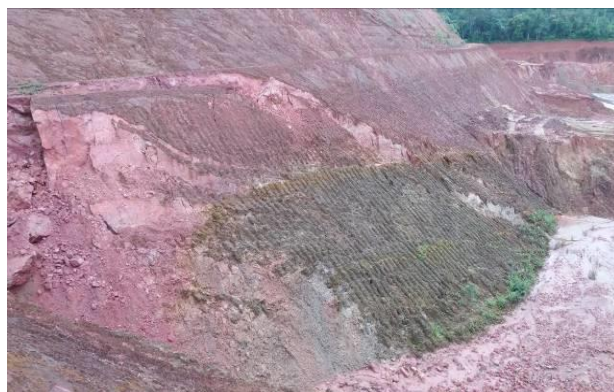
Figura 3. Situação final após ruptura e deslocamento da massa, em maio de 2017.
