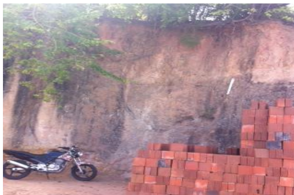
Figura 3 - Vista frontal do talude.
