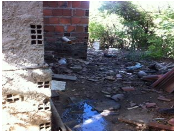
Figura 4 - Descarte inadequado de águas servidas.
