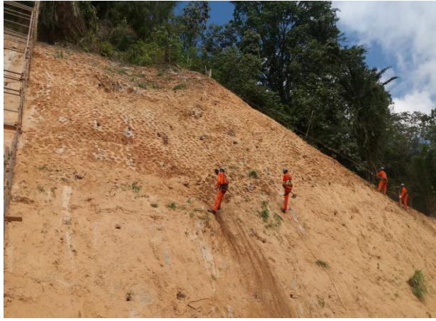
Figura 6. Execução de Coveamento. Fonte: Elaborado pelos autores (2018).
