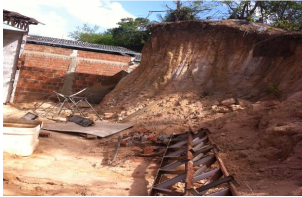
Figura 2 - Corte irregular do talude.
