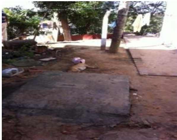
Figura 5 - Fossa séptica no topo do talude.
