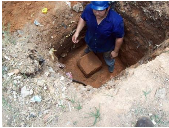
Figura 7. Retirada de bloco indeformada do horizonte composto por aterro lançado.
