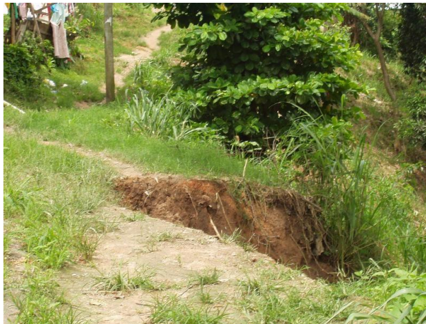
Figura 3. Visão lateral da cicatriz do escorregamento ocorrido no ano de 2005. Fonte: Projeto MAPENCO.
