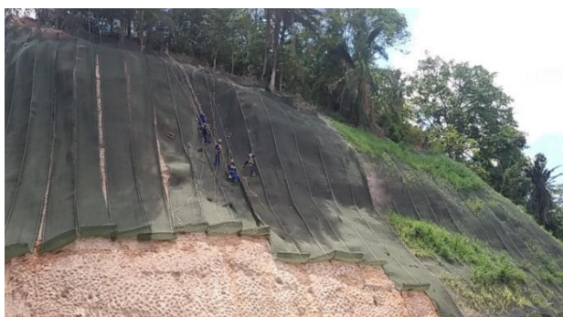
Figura 9. Instalação do Geocomposto no talude.
