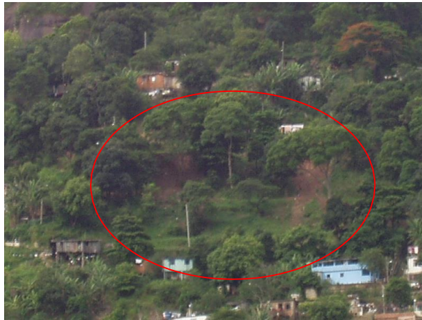
Figura 2. Visão frontal da vertente sul do morro São Benedito. Em destaque, as duas cicatrizes de escorregamentos ocorridos no ano de 2005. Fonte: Projeto MAPENCO.
