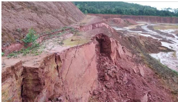
Figura 2. Área após a ruptura, registro de novembro de 2016. Detalhe para a berma interrompida e o desnível gerado.
