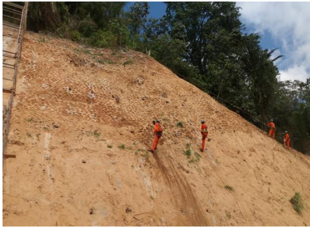
Figura 6. Execução de Coveamento.
