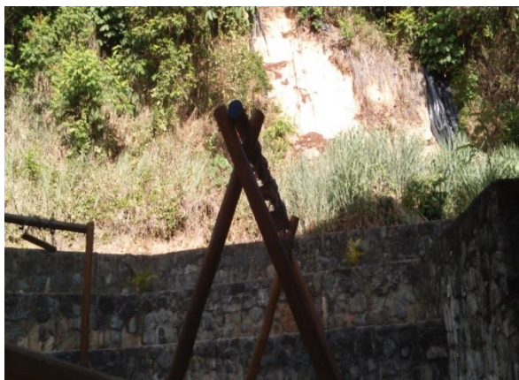
Figura 1. Cicatrizes de ruptura no trecho inferior do talude.
