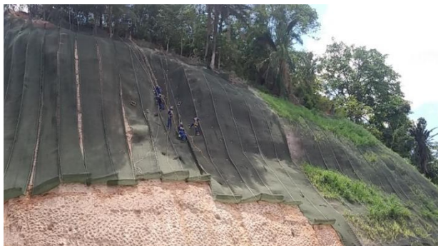
Figura 9. Instalação do Geocomposto no talude. Fonte: Elaborado pelos autores (2018).
