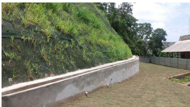
Figura 11. Sistema de drenagem pluvial com muro armado a jusante da encosta.
