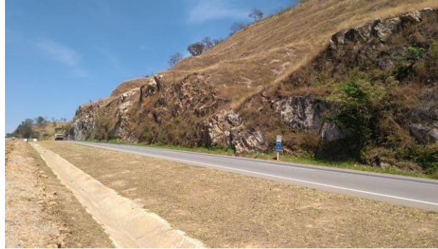
Figura 2. Talude de Pará de Minas.
