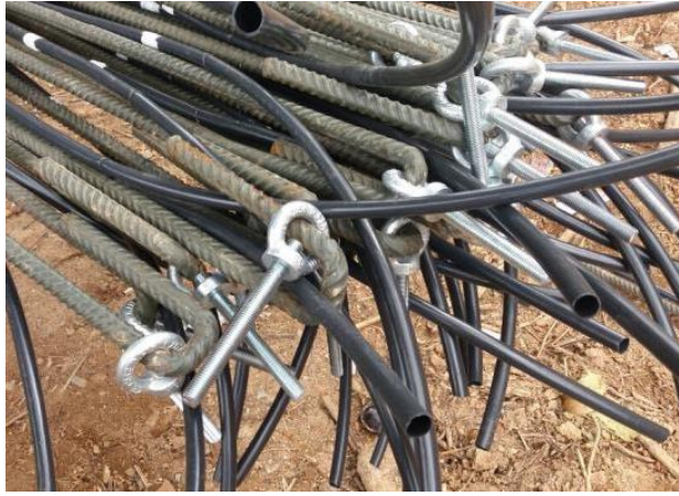
Figura 5. Detalhe do chumbador, porca olhal, barra rosca e mangueira de injeção. Fonte: Elaborado pelos autores (2018).
