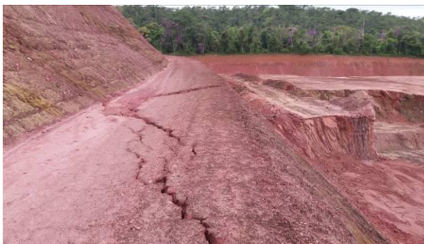
Figura 1. Trincas observadas na berma, em outubro de 2016.
