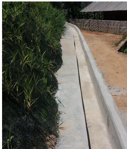
Figura 10. Sistema de drenagem a jusante da encosta. Fonte: Elaborado pelos autores (2018).
