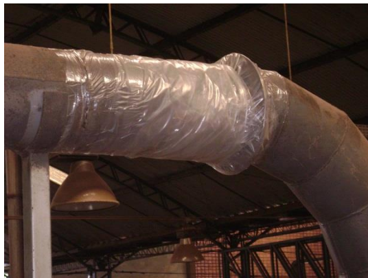
Figura 15 – Tubulação de exaustão com improvisação.
